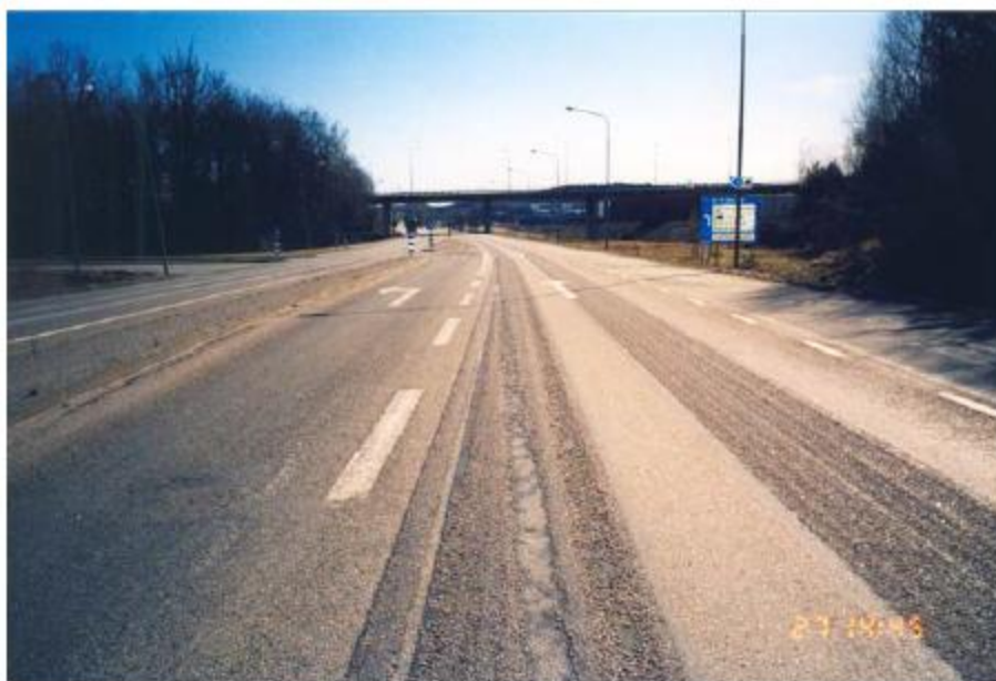
Figur 7. Stensläpp på grund av randning i en spårytbehandling. Foto från Jacobson (2006).
