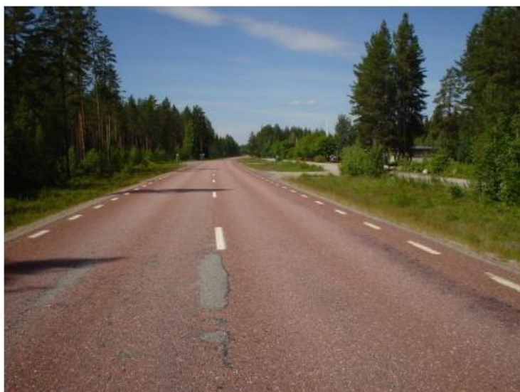
Figur 5. Foto visar ett vägvagnsnitt med släppor nära mittfoggen och i ena hjulspårets kant. Foto från Göransson (2015).
