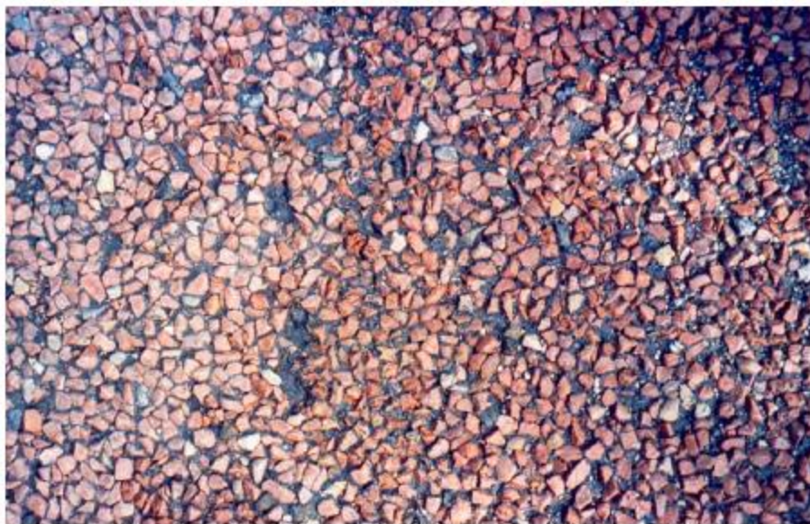
Figur 6. Ett område med utglesning där stenar släppt från ytbehandlingen. Foto från Jacobson (2006).
