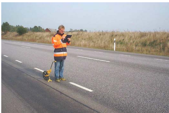
Figur 11 Skadebesiktning av observationssträckor.
