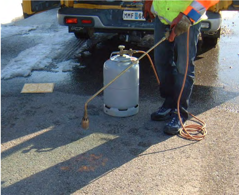
Figur 3 Uppvärmning av vägyta inför fastvärmning av halkvarnare på VTI:s bakgård. Foto: Staffan Möller, VTI.
