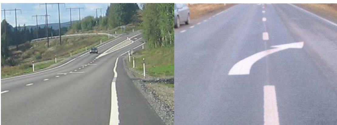
Figur 6 Till vänster: C-korsning rv 87. Foto: Behzad Kouchehi, VTI. Till höger: Närbild pilmarkering. Foto: Berndt Söderholm, Vägverket Region Mitt.
