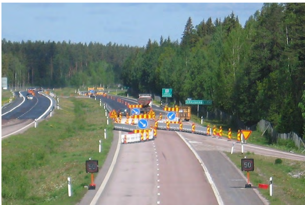
Figur 1 Foto över en del av vägarbetsområdet. Här med utrustning i form av VMS, sidomarkeringsskärmar med pilmönster, rinnande ljus samt vita plaststaket.
