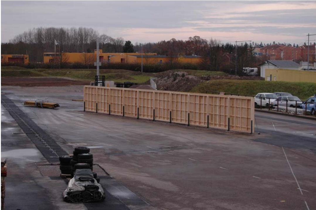
Figur 2 Bullerskärmen sedd från baksidans norra ände.
