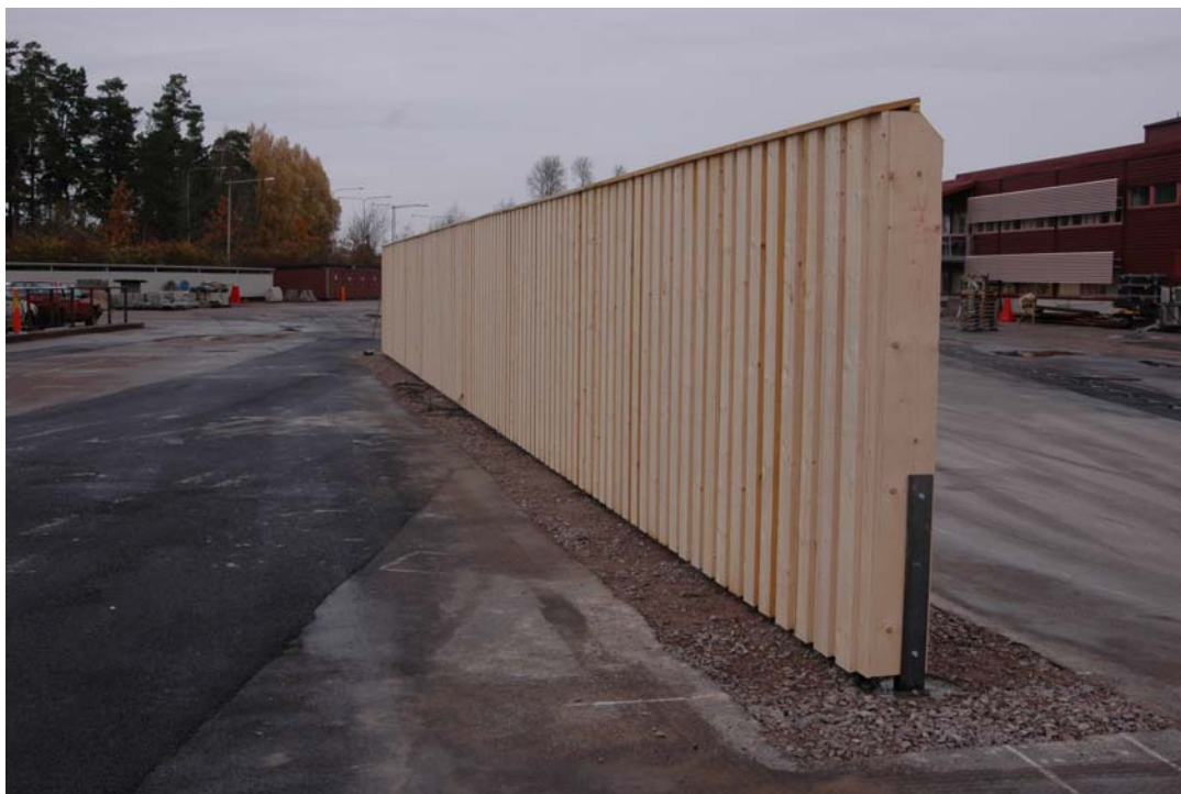
Figur 1 Den färdigmonterade bullerskärmen sedd från framsidans södra del.
