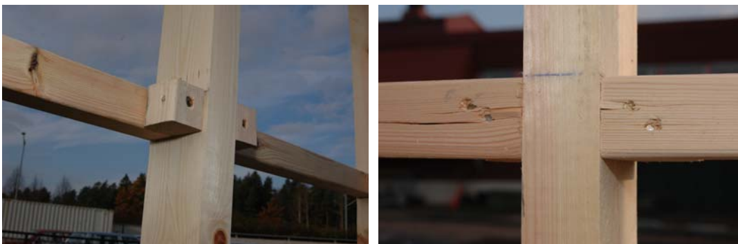
Figur 4 "Klossarna" som används för att fästa de horisontella reglarna. Notera att regelverket på framsidan är helt slätt och att de horisontella reglarna endast är 555 mm långa.
