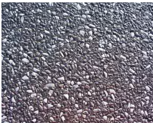
Figur 9 Skelettasfalt med stenstorlek 16 mm.
