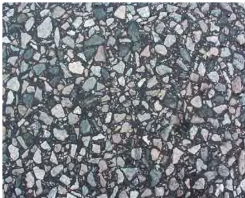
Figur 12 Skelettasfalt med stenstorleken 16 mm.
