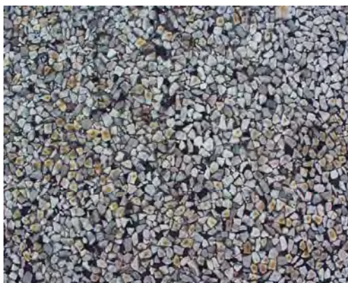
Figur 13 Ytbehandling Y1B med stenstorleken 12 mm.
