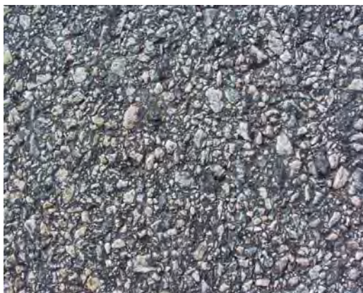
Figur 15 Tät asfaltbetong med stenstorleken 16 mm.
