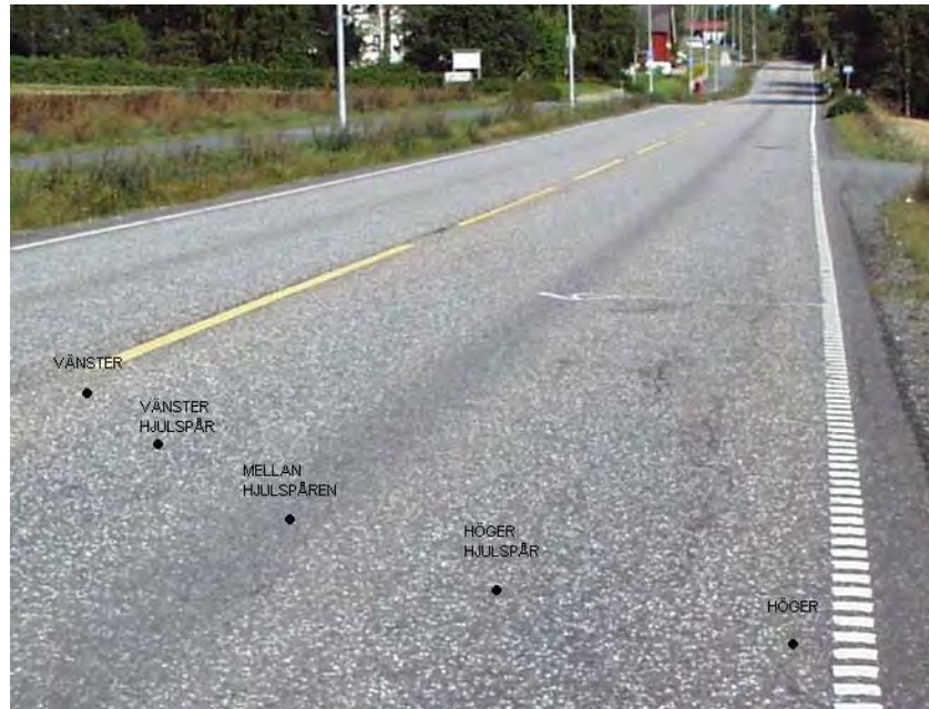
Figur 17 Exempel på mätpunkter tvärs vägen. I detta fall riksväg 22 mellan Trømborg och Løvholen i Norge.
