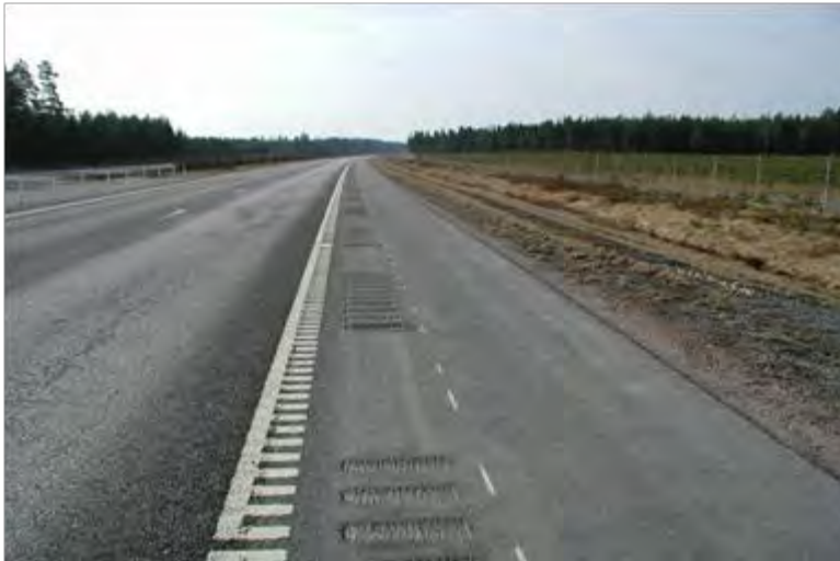
Figur 3 Räfflad linje fräst i vägbeläggningen vid vägrenen.
